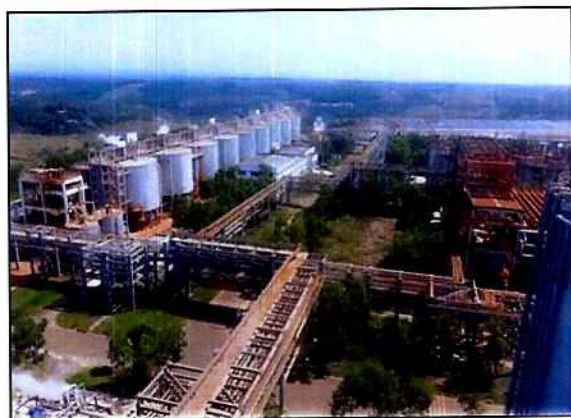
Hình 3.6. Nhà máy Alumin, Đắk R'Lấp (Ảnh: Trịnh Anh)
