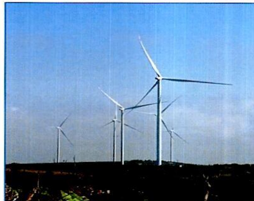
Hình 1.17. Điện gió tại huyện Đắk Song (Ảnh: Minh Thảo)
